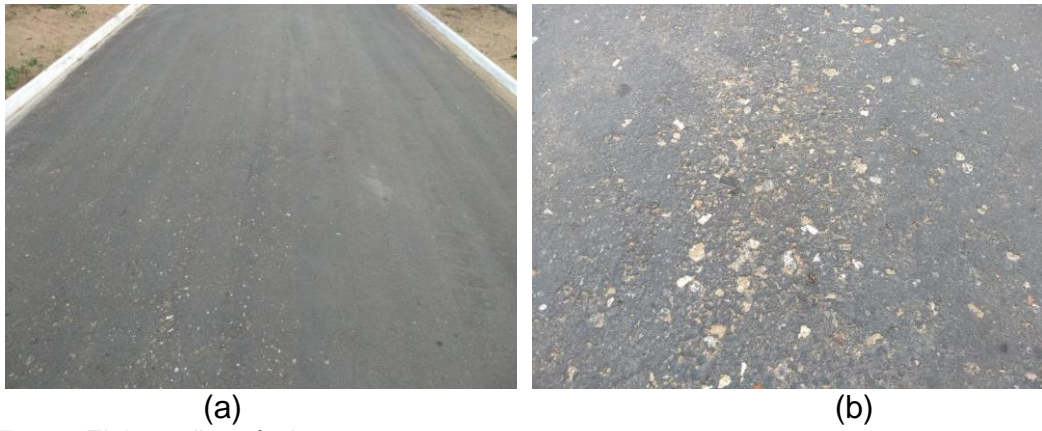
Figura 3 - (a) Comportamento visual dos trechos experimentais com e sem reciclados/(b) Comportamento funcional do trecho experimental com reciclados
