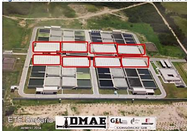
Figura 5 - Visão panorâmica da ETE Serraria com destaque aos UASBs
